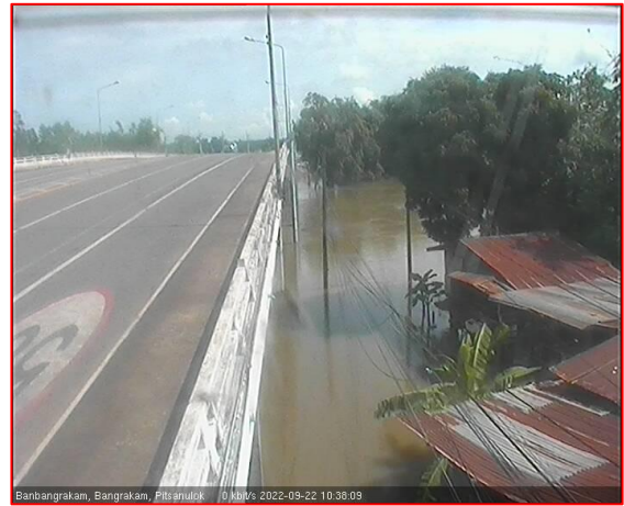
สะพานบ้านบางระกำ ต.บางระกำ อ.บางระกำ จ.พิษณุโลก
