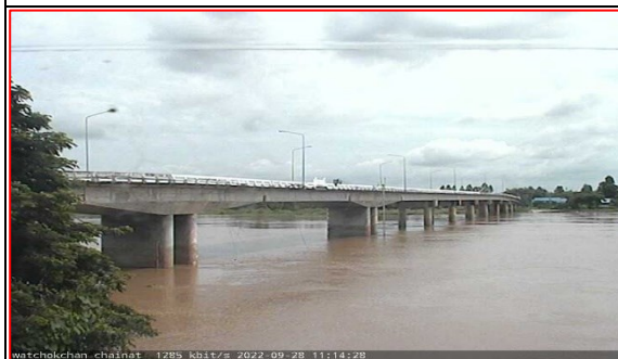
วัดโคกจันทร์ ต.โพนางดำ อ.สรรพยา จ.ชัยนาท (ลุ่มน้ำเจ้าพระยา)
