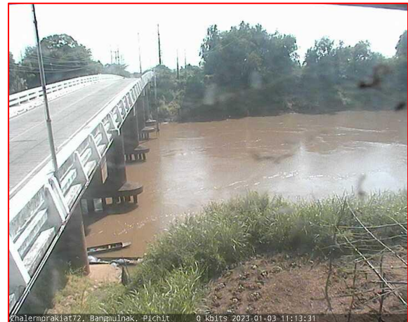
สะพานเฉลิมพระเกียรติ ร.9 72 พระธา ต.เนินมะกอก อ.บางมูลนาก จ.พิจิตร
