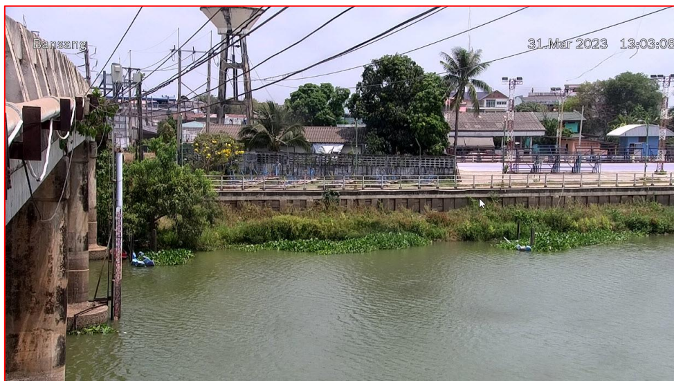
สถานีบ้านสร้าง ต.บ้านสร้าง อ.บ้านสร้าง จ.ปราจีนบุรี (ลุ่มน้ำบางปะกง – แม่น้ำปราจีนบุรีตอนล่าง)
