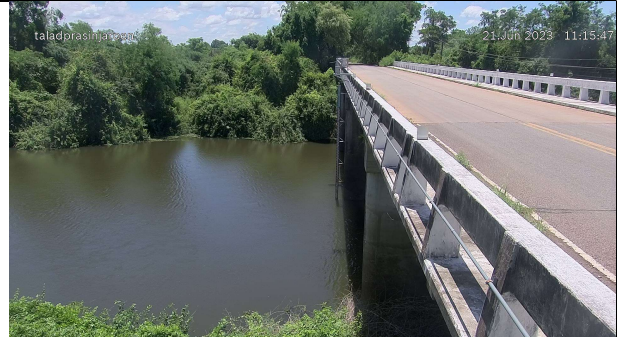
CCTV ตลาดปลาสินเจริญ ต.เตาไห อ.เพ็ญ จ.อุดรธานี TC031702
