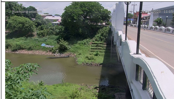
CCTV สะพานห้วยหลวงอนุสรณ์ ต.จุมพล อ.โพนพิสัย จ.หนองคาย TC031703
