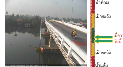
สะพานบุญรัตนประชานูวัฒน์ - อ.สามพราน จ.นครปฐม (ลุ่มน้ำท่าจีน)
