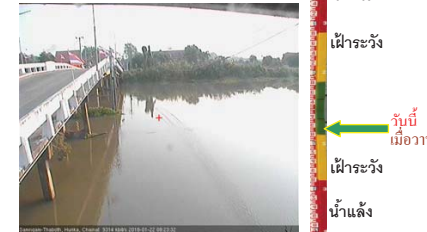
สะพานสามงาม-ท่าโบสถ์ อ.หันคา จ.ชัยนาท (ลุ่มน้ำท่าจีน)
