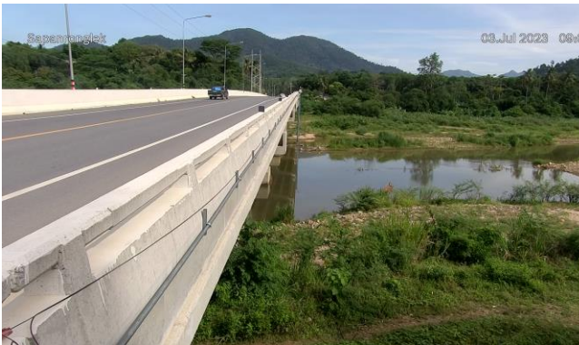
TC191802 : สะพานบ้านโรงเหล็ก ต.นบพิตำ อ.นบพิตำ จ.นครศรีธรรมราช
