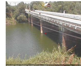
บ้านเหล่านกขุม - อ.เมือง จ.ขอนแก่น (ลุ่มน้ำชี)
