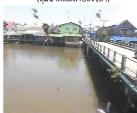
สถานีลำปำ - อ.เมือง จ.พัทลุง (ลุ่มน้ำทะเลสาบสงขลา)
