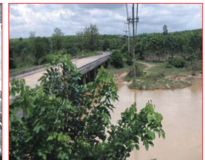
สถานีบ้านม่วงก้อง - อ.สะเดา จ.สงขลา (ลุ่มน้ำทะเลสาบสงขลา)
