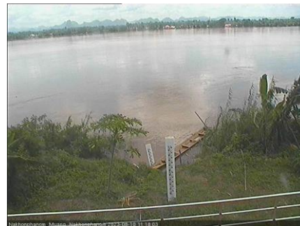
สถานีวัดระดับน้ำอัตโนมัติ - อ.เมือง จ.นครพนม (ลุ่มน้ำโขงตะวันออกเฉียงเหนือ)
