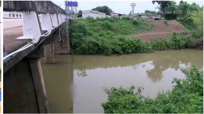
TC150105 : บ้านเก่าเขาฉกรรจ์ ต.หนองหัว อ.เขาฉกรรจ์ จ.สระแก้ว
