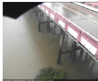
วัดศรีชมพูนาคค้อ - อ.ท่าบ่อ จ.หนองคาย (ห้วยโสมง/โขงอีสาน)
