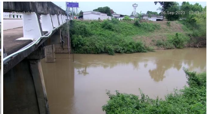
TC150105 : บ้านเก่าเขาฉกรรจ์ ต.หนองหว่า อ.เขาฉกรรจ์ จ.สระแก้ว
