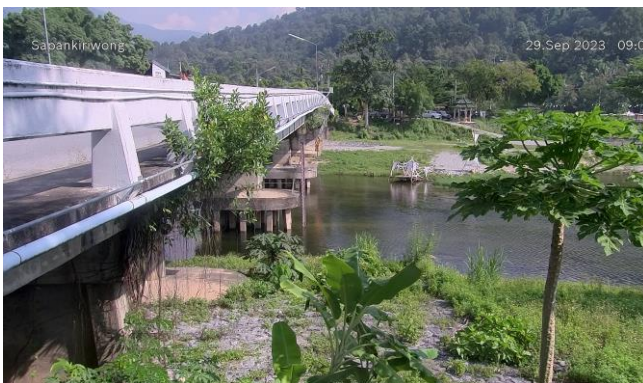
TC191913 : สะพานคีรีวง ต.กำโลน อ.ลานสกา จ.นครศรีธรรมราช
