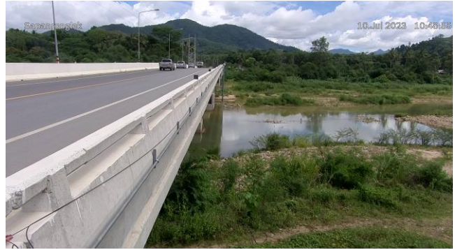
TC191802 : สะพานบ้านโรงเหล็ก ต.นบพิตำ อ.นบพิตำ จ.นครศรีธรรมราช
