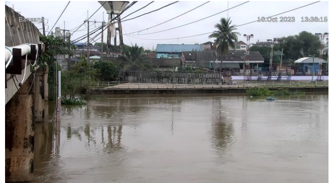
TC150503 : บ้านสร้าง ต.บ้านสร้าง อ.บ้านสร้าง จ.ปราจีนบุรี
