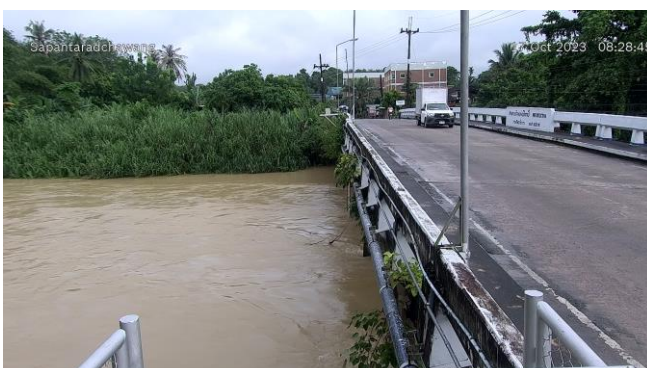
TC191001 : สะพานข้ามแม่น้ำตาปี ตลาดฉวาง ต.ฉวาง อ.ฉวาง จ.นครศรีธรรมราช
