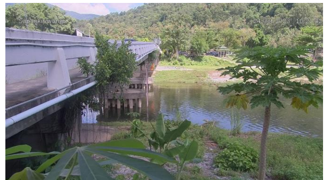
TC191913 : สะพานคีรีวง ต.กำโลน อ.ลานสกา จ.นครศรีธรรมราช
