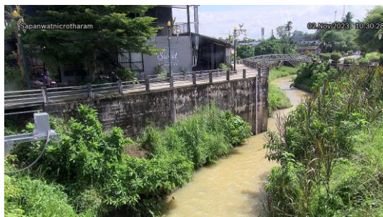
TC220509 : สะพานวัดนิโครธาราม ต.ทับปุด อ.ทับปุด จ.พังงา
