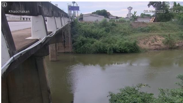
TC150105 : บ้านเก่าเขาฉกรรจ์ ต.หนองหัว อ.เขาฉกรรจ์ จ.สระแก้ว
