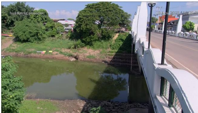
TC031703 : สะพานห้วยหลวงอนุสรณ์ ต.จุมพล อ.โนนพิสัย จ.หนองคาย
