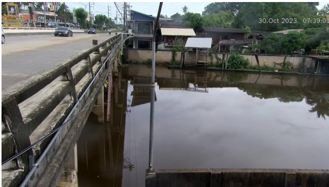
TC191911 : สะพานวัดท่าแพ ต.ปากพูน อ.เมือง จ.นครศรีธรรมราช
