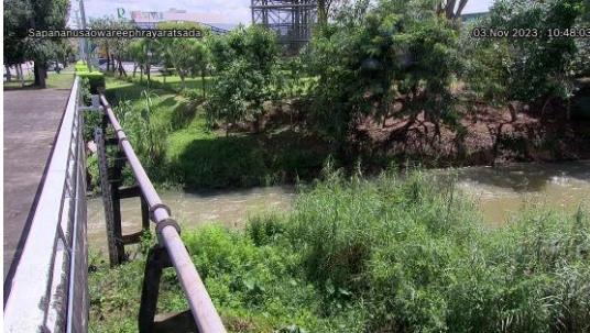
TC220904 : สะพานอนุสาวรีย์พระยารัษฎานุประดิษฐ์ มทิสรรักดี ต.ทับเที่ยง อ.เมืองตรัง จ.ตรัง
