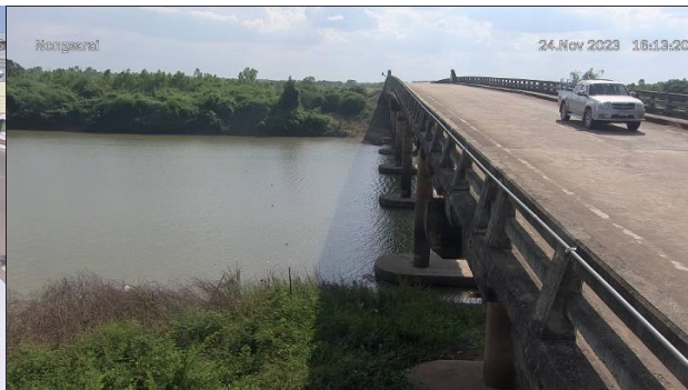
TC032706 : หองสาทราย ต.พนอม อ.ท่าอุเทน จ.นครพนม
