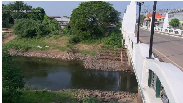
TC031703 : สะพานห้วยหลวงอนุสรณ์
