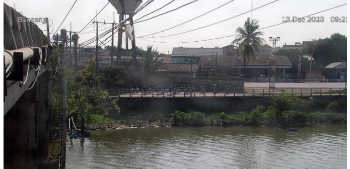
TC150503 : บ้านสร้าง ต.บ้านสร้าง อ.บ้านสร้าง จ.ปราจีนบุรี
