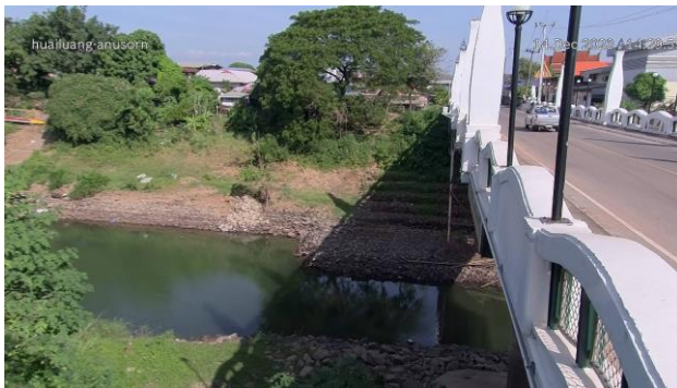
TC031703 : สะพานห้วยหลวงอนุสรณ์
