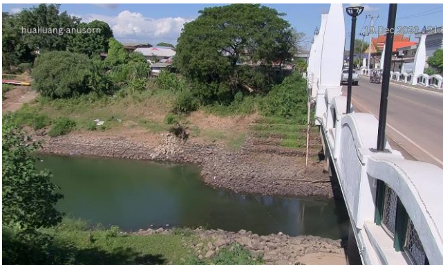
TC031703 : สะพานห้วยหลวงอนุสรณ์
