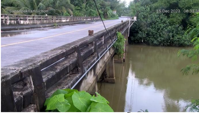
TC191705 : สะพานปากน้ำสิชล ต.สิชล อ.สิชล จ.นครศรีธรรมราช
