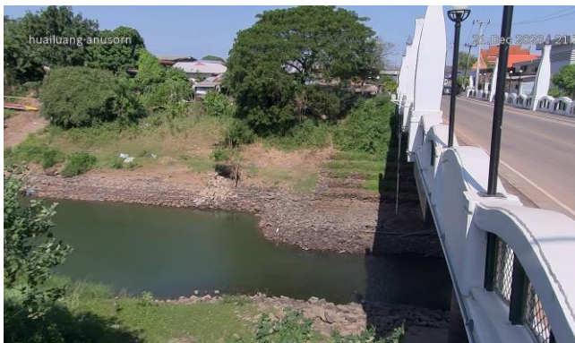
TC031703 : สะพานห้วยหลวงอนุสรณ์ ต.จุมพล อ.โพนพิสัย จ.หนองคาย
