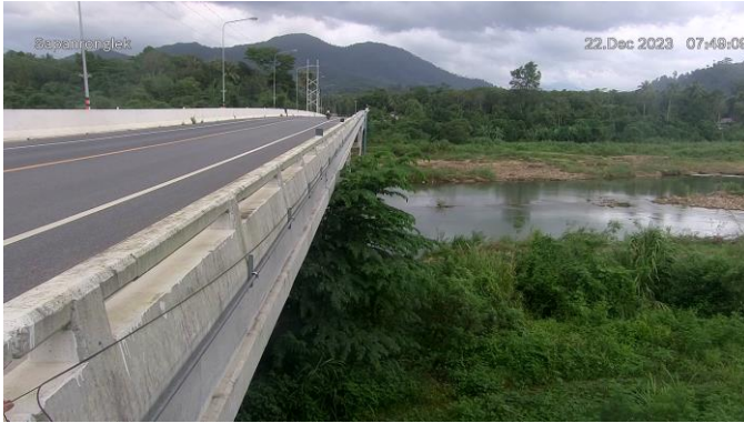
TC191802 : สะพานบ้านโรงเหล็ก ต.นบพิต อ.นบพิต จ.นครศรีธรรมราช
