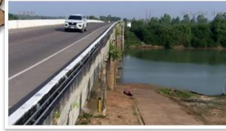
TC032705 : สะพาน uw4059 ต.ท่าบ่อสงคราม อ.ศรีสงคราม จ.นครพนม
