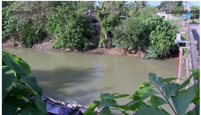
TC221203 : สะพานบ้านนาลาน ต.ควนขัน อ.เมืองสตูล จ.สตูล
