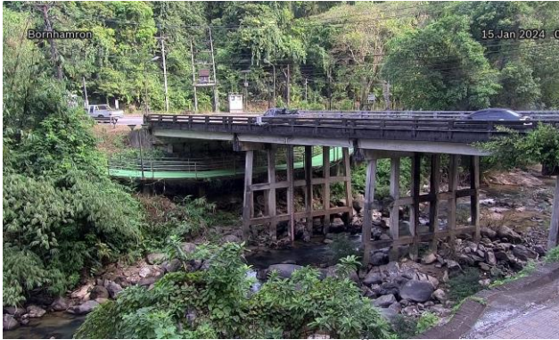
TC220303 : สะพานบ่อน้ำร้อน ต.บางรีน อ.เมืองระนอง จ.ระนอง
