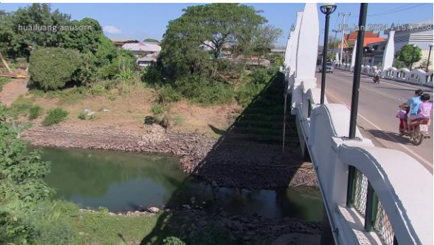
TC031703 : สะพานห้วยหลวงอนุสรณ์ ต.จุมพล อ.โพนพิสัย จ.หนองคาย
