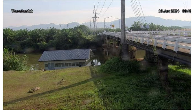
TC220402 : สะพานท่านเจ้าฟ้า ต.ตะกั่วป่า อ.ตะกั่วป่า จ.พังงา
