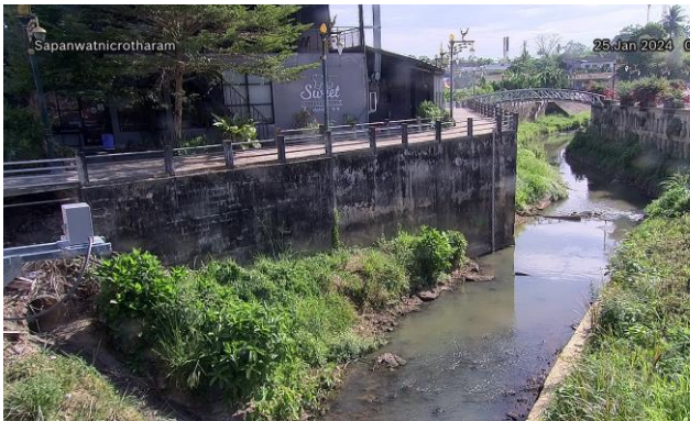
TC220509 : สะพานวัดนิโครธาราม ต.ทับปุด อ.ทับปุด จ.พังงา
