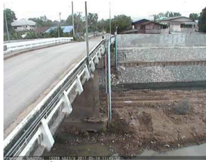
สะพานพระแม่ย่า - อ.เมือง จ.สุโขทัย (ลุ่มน้ำยม)
