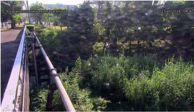
TC220904 : สะพานอนุสาวรีย์
