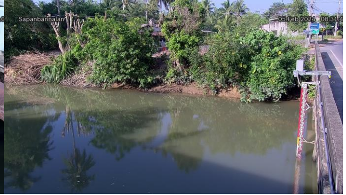
TC221203 : สะพานบ้านนาลาน
