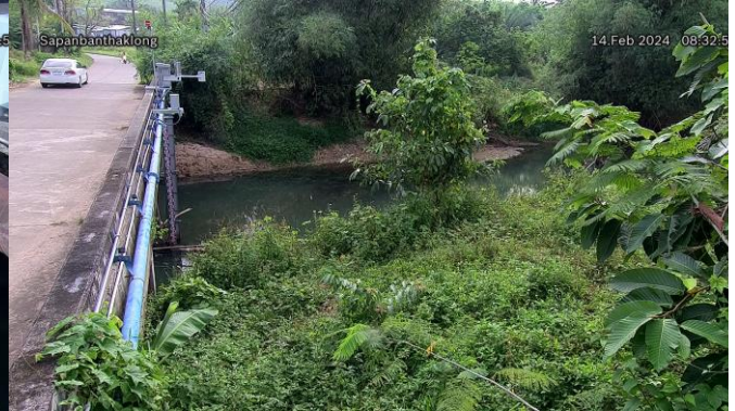
TC220512 : สะพานบ้านท่าคลอง ต.ทับปริก อ.เมืองกระบี่ จ.กระบี่
