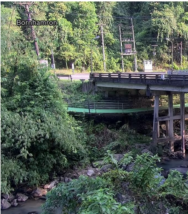
TC220303 : สะพานบ่อน้ำร้อน ต.บางรีน อ.เมืองระนอง จ.ระนอง
