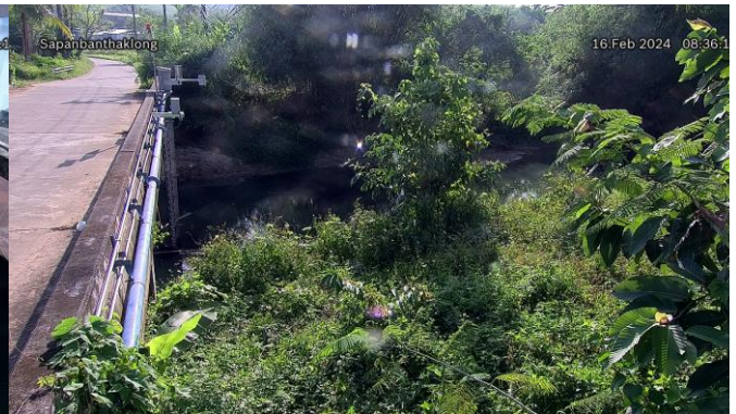
TC220512 : สะพานบ้านท่าคลอง ต.ทับปริก อ.เมืองกระบี่ จ.กระบี่
