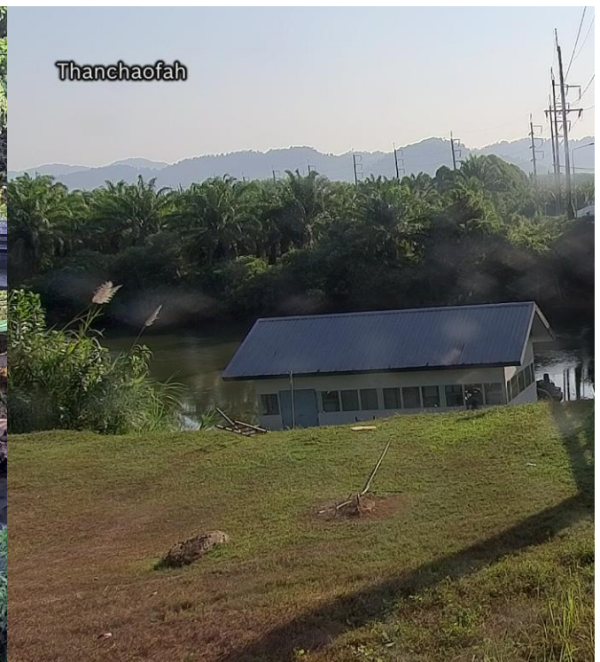
TC220402 : สะพานท่านเจ้าฟ้า ต.ตะกั่วป่า อ.ตะกั่วป่า จ.พังงา
