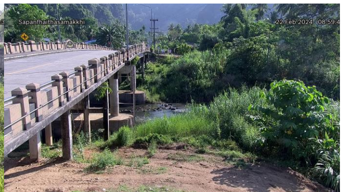
TC220510 : สะพานฝ่ายท่าสามคี ต.ถ้ำน้ำมุด อ.เมืองพังงา จ.พังงา
