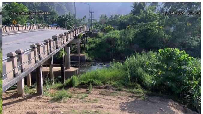
TC220510 : สะพานฝ่ายท่าสามัคคี ต.ถ้ำน้ำผุด อ.เมืองพังงา จ.พังงา
