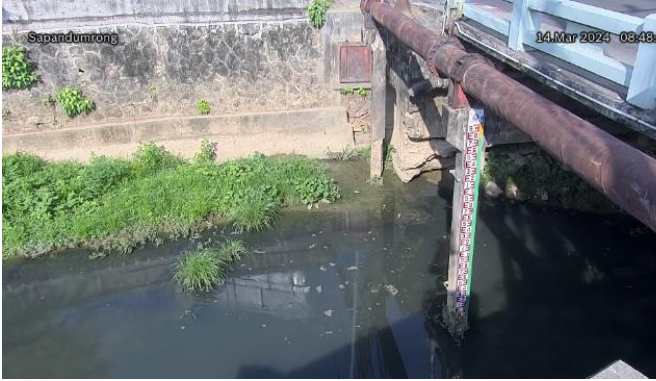
TC220605 : สะพานตำรัง ต.ตลาดใหญ่ อ.เมืองภูเก็ต จ.ภูเก็ต
