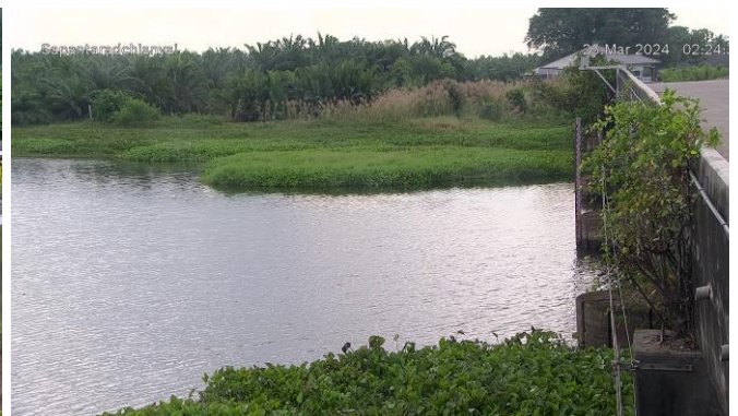
TC191918 : สะพานตลาดเข็รใหญ่ ต.เข็รใหญ่ อ.เข็รใหญ่ จ.นครศรีธรรมราช
