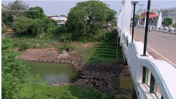
TC031703 : สะพานห้วยหลวงอนุสรณ์ ต.จุมพล อ.โพธิ์พิสัย จ.หนองคาย
