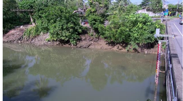
TC221203 : สะพานบ้านนาลาน ต.ควนขัน อ.เมืองสตูล จ.สตูล
