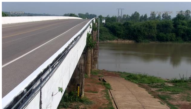
TC032705 : สะพาน นพ.4059 ต.ท่าบ่อสงคราม อ.ศรีสงคราม จ.นครพนม
